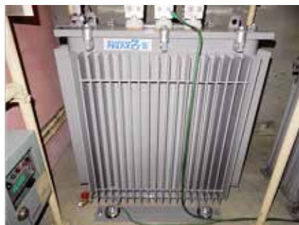
図表6-12. 2号館電気室内アモルファス変圧器(4台一斉更新)
