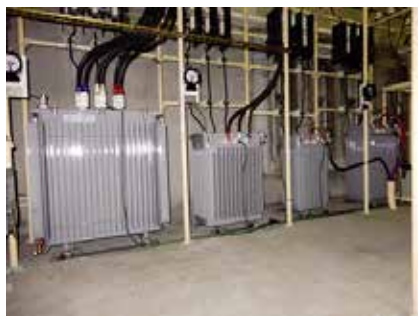
図表6-12. 2号館電気室内アモルファス変圧器(4台一斉更新)
