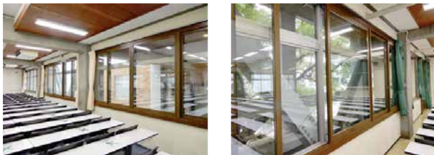
図表6-11. 421教室の内窓断熱(Low-E複層ガラス)
