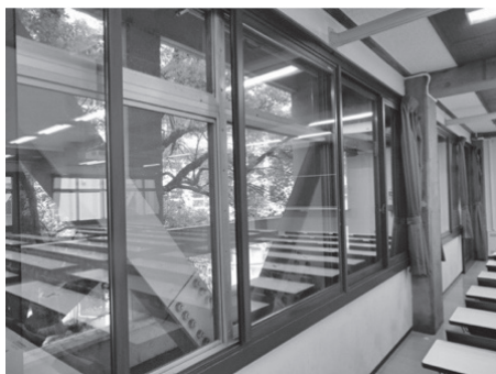
図4 421教室の内窓断熱(Low-e 複層ガラス)施工
