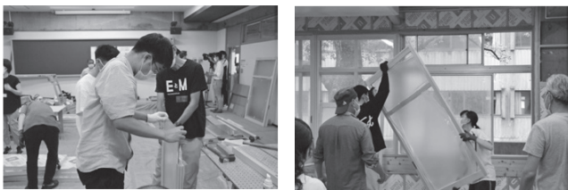
図3 413教室の内窓製作と壁断熱化の作業風景
