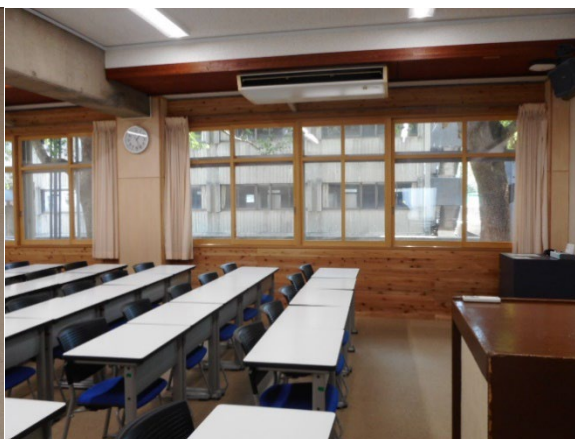
二重窓と断熱材を貼り付けた壁
