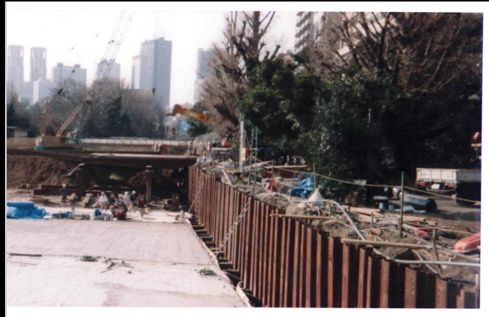
御苑トンネル工事中の写真 (1988年頃)
