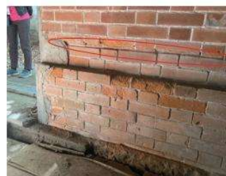
レンガ欠き込みの様子
