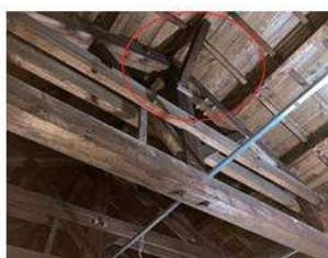
King Post Trussの断面
