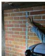
レンガのモジュール実測 （4段9寸、8段18寸）
